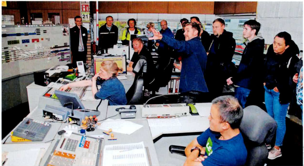
Blick hinter die Kulissen: Zwei Stellwerke unterschiedlicher Generationen sichern den Zugbetrieb ab. Das Bild zeigt die Fahrdienstleiter im dritten Stock des älteren Stellwerks.
